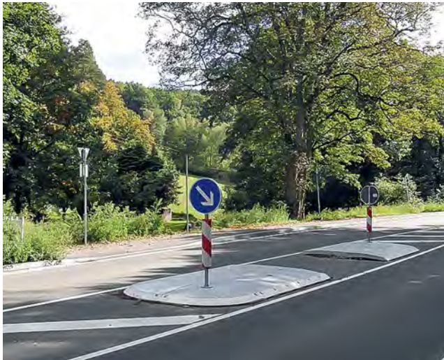
Mit den Reflektoren sind die Verkehrsinseln auch in der Nacht gut sichtbar.
